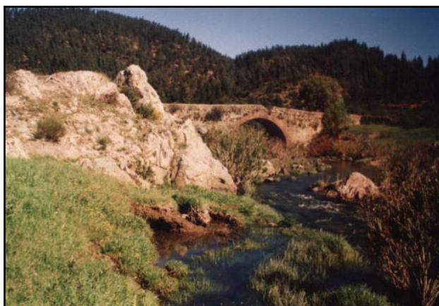
Puente Viejo (Campofrío)
