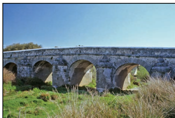
Puente del Cala (Santa Olalla del Cala)
