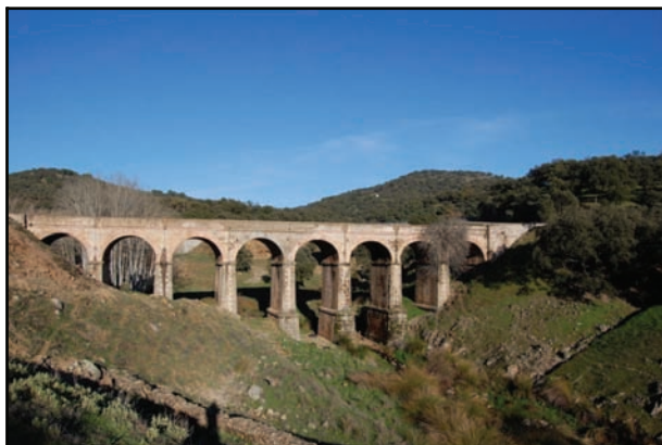
Puente de la Gitana (Arroyomolinos de León)
