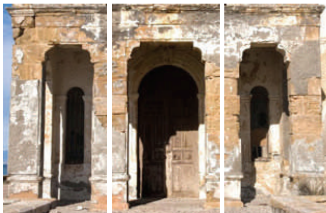
Portada con atrio in antis, puerta de madera con arco de medio punto y ventanas asaetadas.
