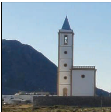
Imagen de la iglesia tras el final de los trabajos de restauración en 2012.
