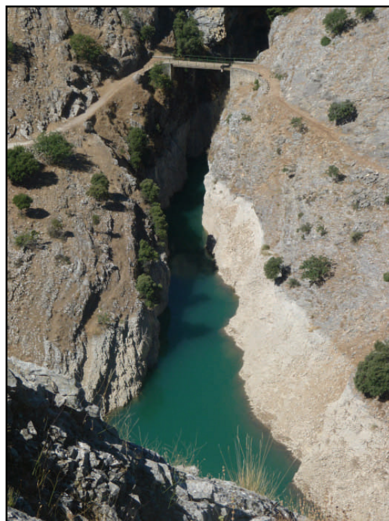
Foto aérea del puente nuevo sobre el profundo tajo de la Cerrada y las marcas de cota máxima del pantano.
