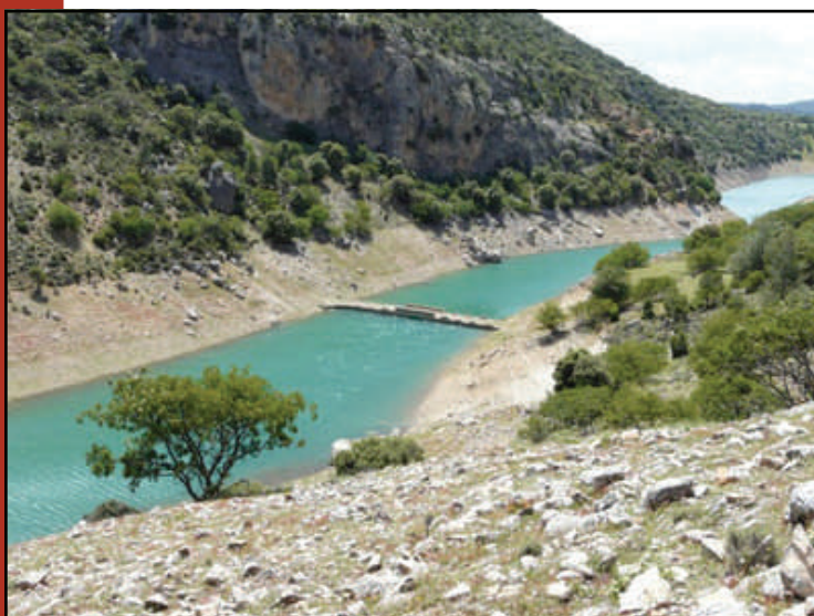
La cola del embalse a medio llenar muestra la parte superior del puente
