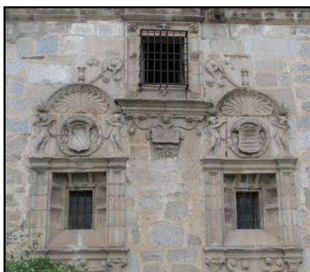
Ventanas de la sacristía
