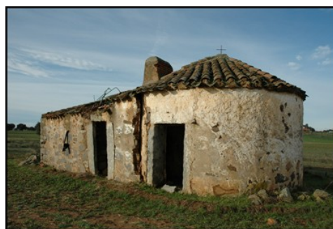
Chozo de cúpula tejada. Los Caños (Hinojosa)
