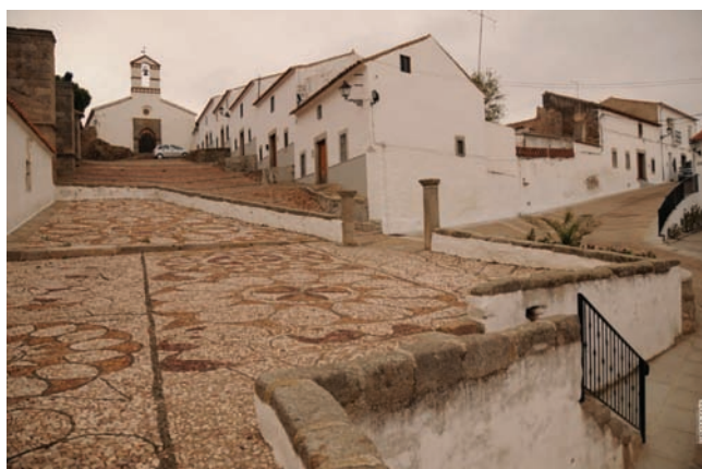
Recuperación del entorno viario de la Iglesia del Salvador, Pedroche
