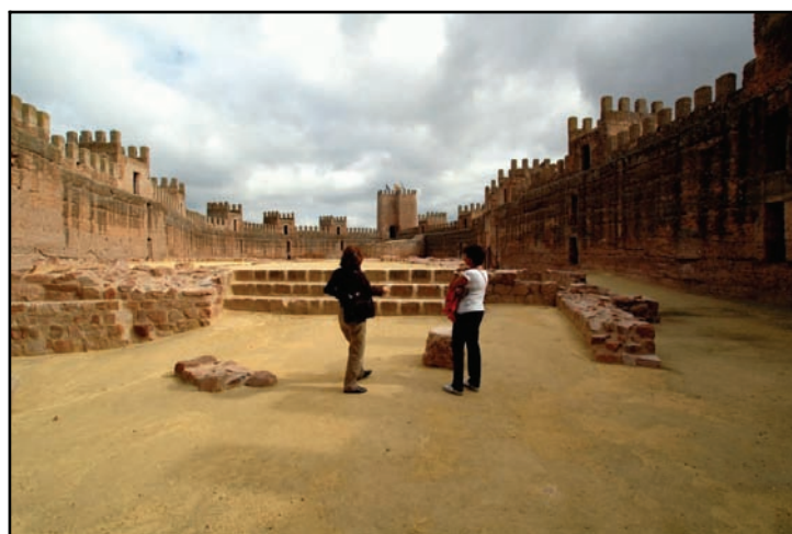
Escalinata de acceso a la meseta central del castillo (mausoleo funerario de Ilicia); en primer plano y a los pies de los visitantes uno de los capiteles. Fotografía: Culmina.
